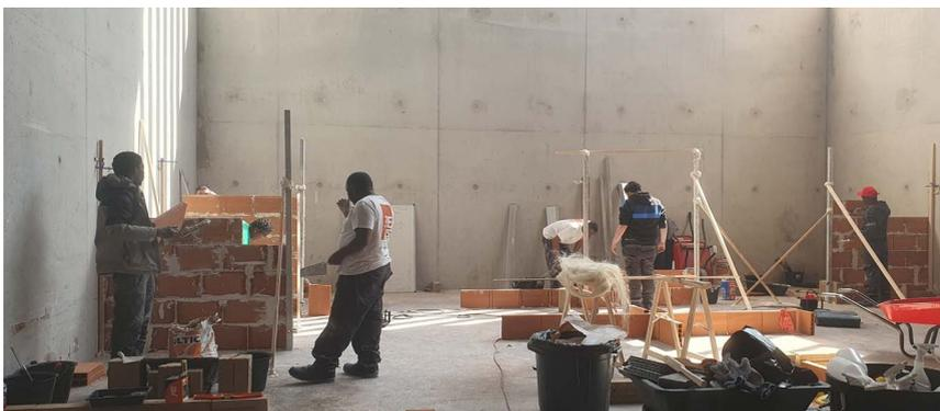
*Elevation de murets pour cloisonner les zones de travail - MCDM 2023*
