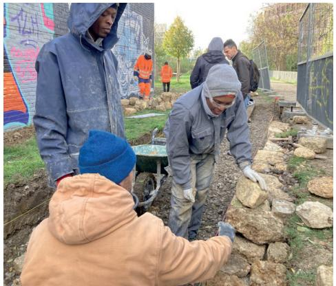
Il s'agit de la première formation certificante portée par Édifice, qui a pris la forme d'un chantier apprenant sur la construction en pierre sèche, à partir de pierres de réemploi. Le chantier s'est déroulé à Paris 19ème et a permis de créer une rampe PMR pour l'accessibilité du tiers lieu TLM. Les 5 stagiaires participants ont obtenu la certification.
